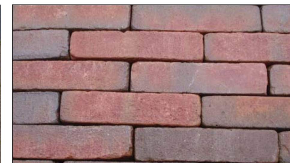
Gebakken klinker Kleur en afmeting als aanwezige gebakken klinkers
